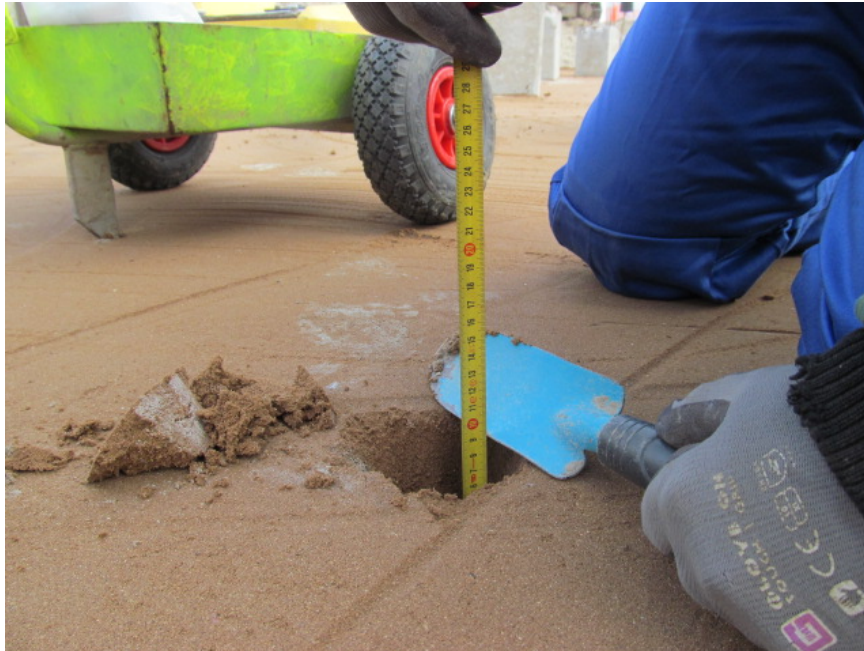
Foto: Controle van dikte van minerale laag.
