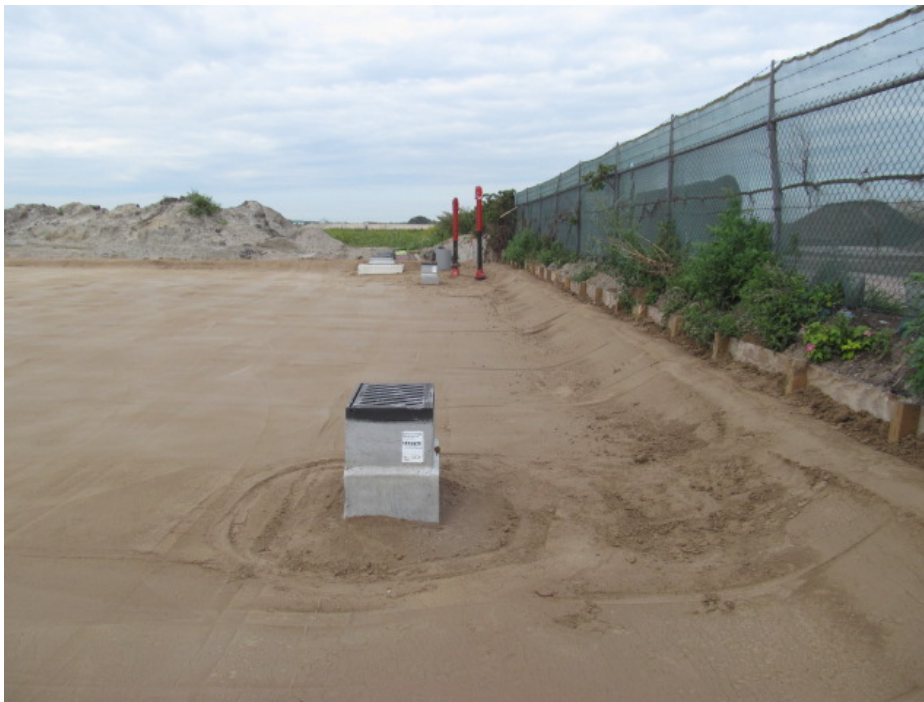
Foto: Doorvoer in voorziening.
