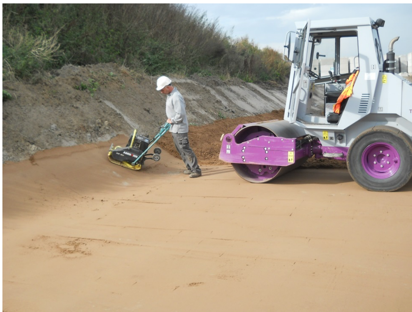
Foto: Voorbeeld van aanbrengen van voldoende afschot.
