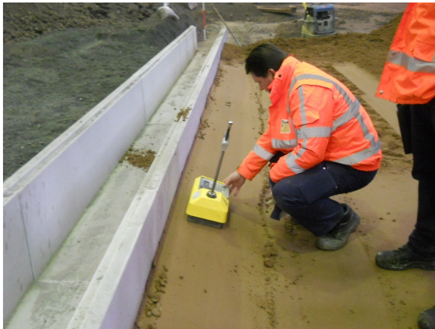
Foto: Voorbeeld van proef ter plaatse van slecht te verdichten locatie.
