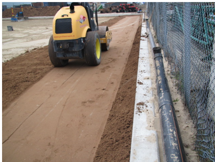
Foto: Aanbrengen van zand-bentonietpolymeergemengsel.
