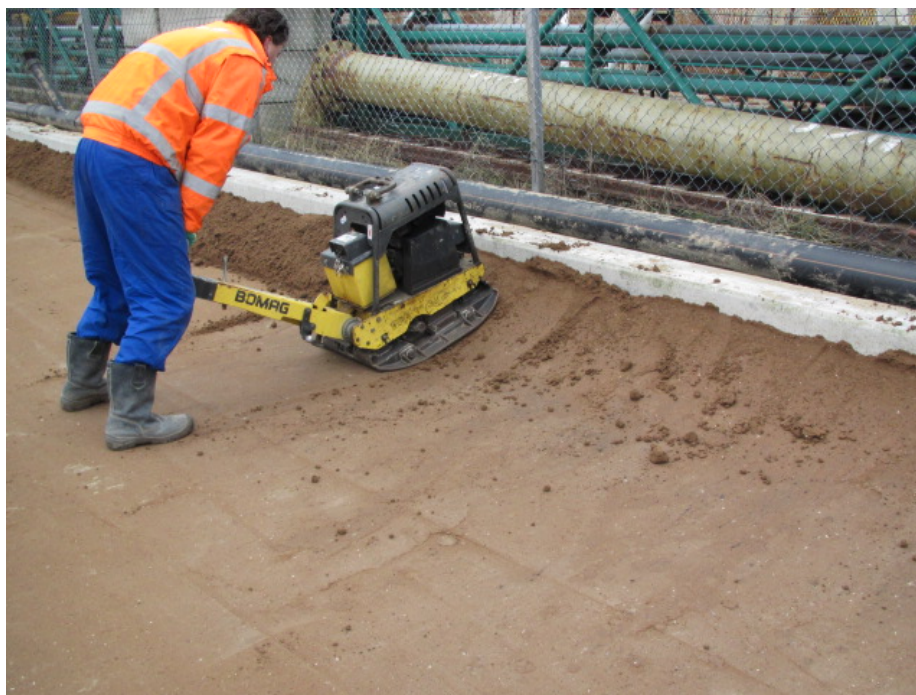
Foto: Aanbrengen minerale laag ter plaatse van slecht te verdichten locatie.
